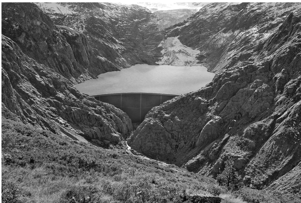
写真—5 トリフトダム完成予想写真
